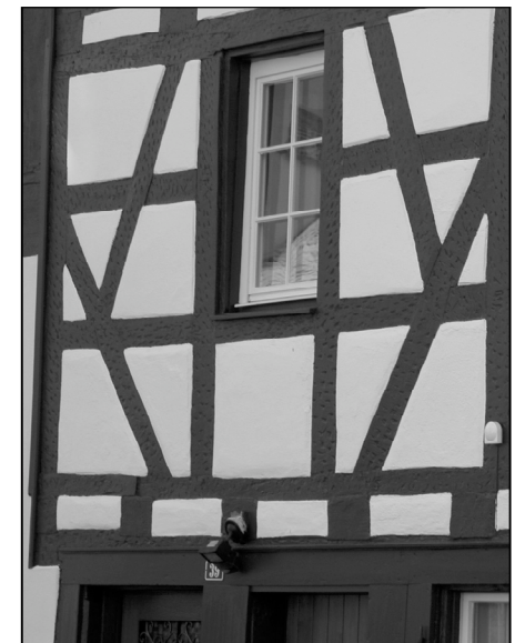
Fassadenausschnitt an der Hintergasse
