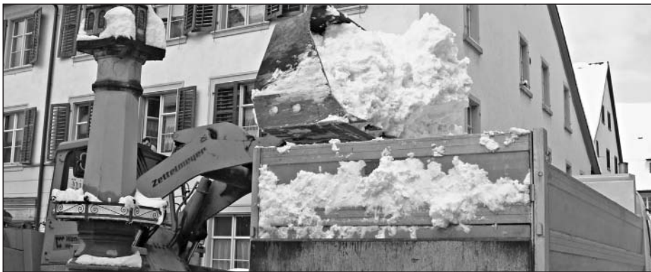
Für die ununterbrochene Schneeräumung musste sogar schweres Gerät eingesetzt werden.
