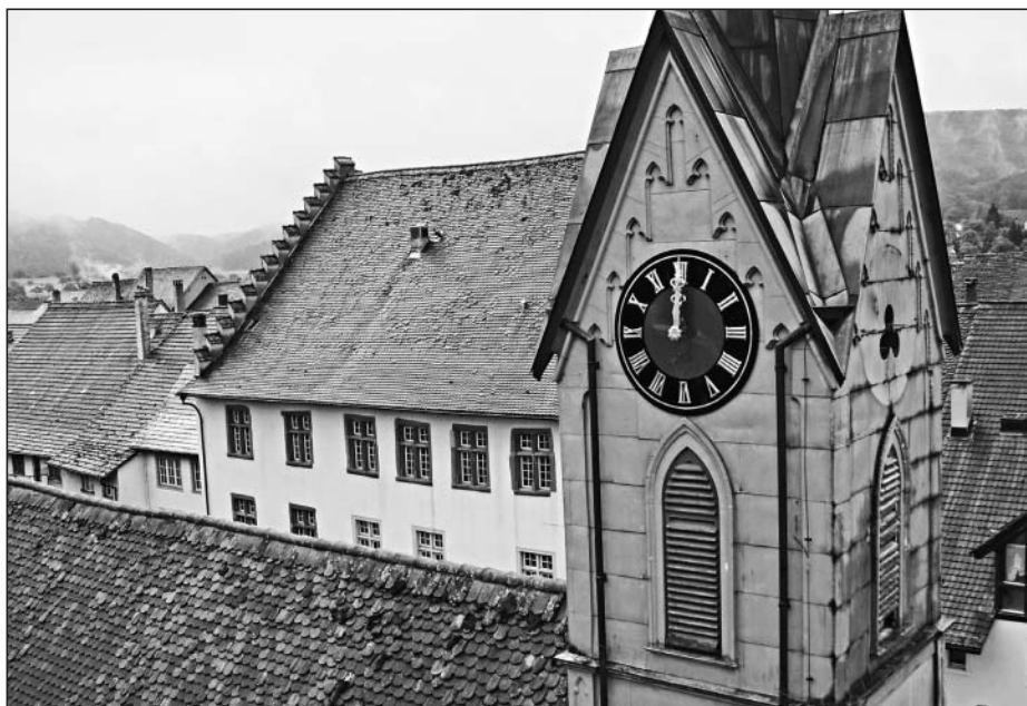
Mit der Uhrenmontage erhielt das Städtli (im Hintergrund das Gemeindehaus) seine Zeit zurück.
