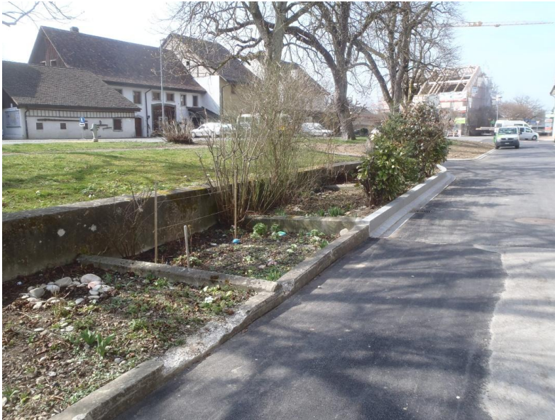
neue und bestehende Betonmauer
