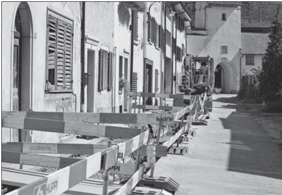
Die Herrngasse musste einer dringenden Sanierung unterzogen werden.
