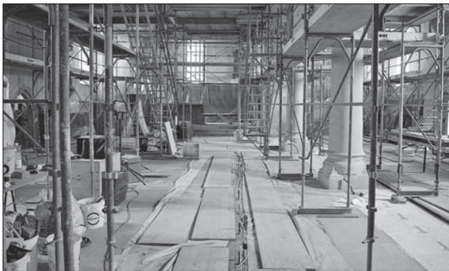
Das Innere der Neunkircher Bergkirche wird während Monaten saniert.
