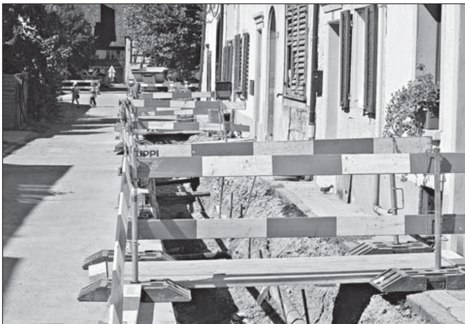
Während Monaten wurde in der Herrengasse gegraben, saniert und wieder zugeschüttet. tm.-
