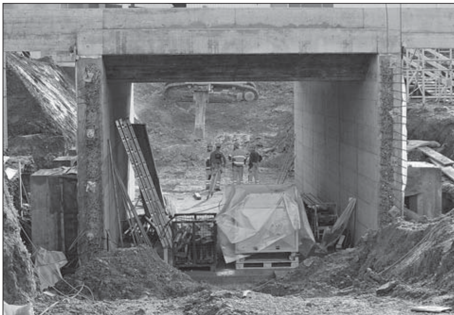
Drei Monate nach dem Spatenstich wird die vorfabrizierte Unterführung eingeschoben.
