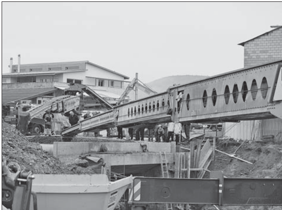
Über zwei lange Förderbänder wurden Unmengen von Beton in die Grube eingefüllt.
