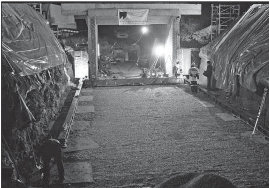
Die Einschubarbeiten im Langfeld dauerten drei lange Tage und ebensolche Nächte.
