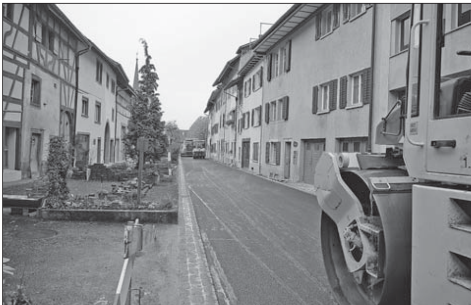
Noch vor dem Winter- und Kälteeinbruch wurde der Strassenbelag eingebaut.
