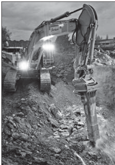
Der Bagger nagt sich durch den Fels. tm.-
