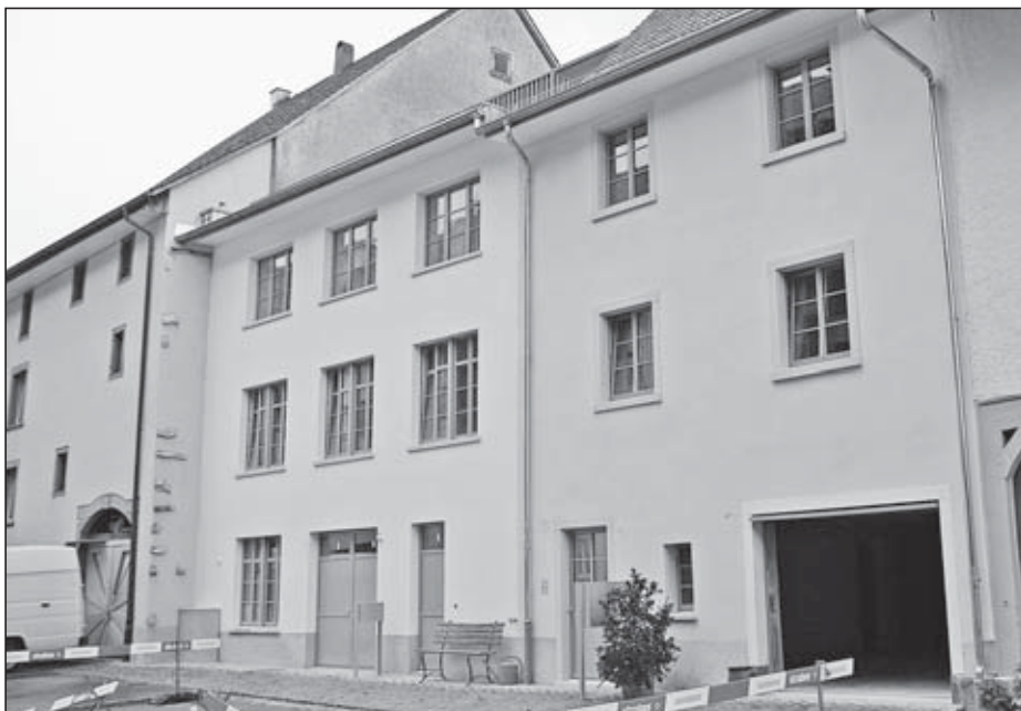
Nach der Sanierung und dem Umbau zeigt sich die Hintergasse 19 im neuen Kleid.
