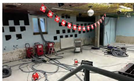
Trocknen von Boden und Wänden
